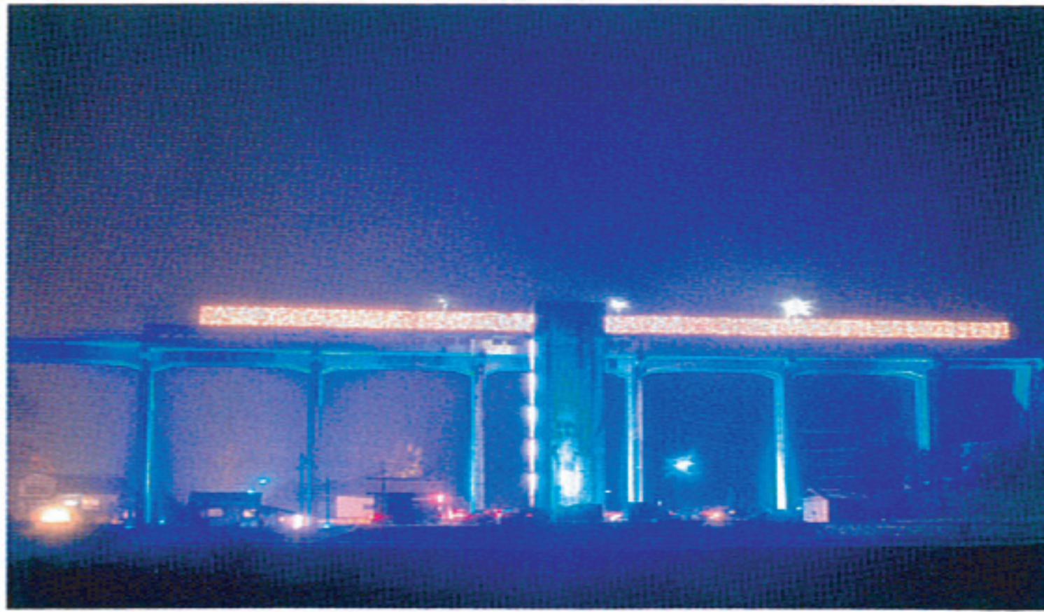
トリコンが製造したLEDでライトアップされたJR三江線宇都井駅のホームと橋脚＝2010年12月
